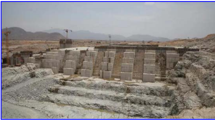
أعمال البناء في سد النهضة
